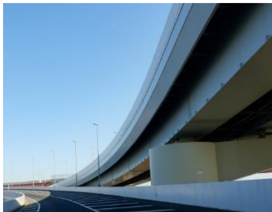
▶ 橋梁・高速道路の箱桁内部
