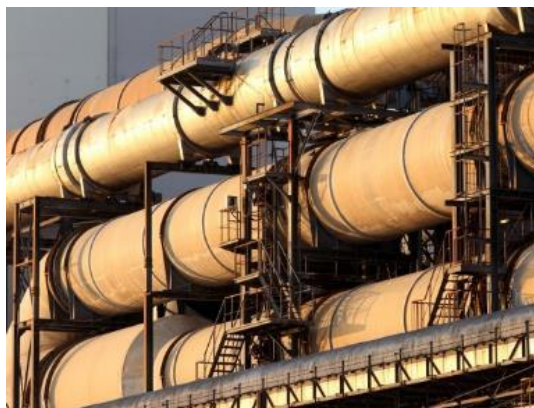
▶ 配管 (ダクト) 内部
