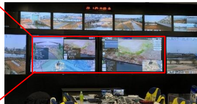
河川事務所対策室のモニターにて監視
